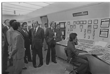
Visita de Walter Rosa, ministro da Indústria e Tecnologia, e António Maldonado Gonelha, secretário de Estado do Trabalho, à Central Térmica do Carregado. Fotografia de Inácio Ludgero. FMSMB / Arquivo Inácio Ludgero. 12277.035.016
