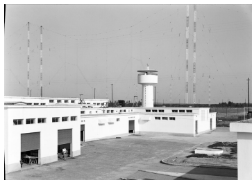
Exteriores das instalações do centro emissor da RARET- Sociedade Anónima de Rádio Retransmissão, em Glória do Ribatejo (Santarém). Fotografia sem data de Mário Novais. Fonte: Biblioteca de Arte/ Fundação Calouste Gulbenkian, CFT003.73383
